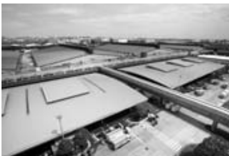
東京都中央卸売市場大田市場（南側屋根付積込場）
