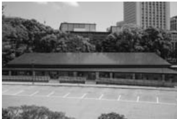
皇居外苑楠公休憩所太陽光発電設備設置工事（東京都千代田区） 施工／ノエマエンジニアリング 製品／マッターラソーラールーフⅡ（136.4kW仕様）
