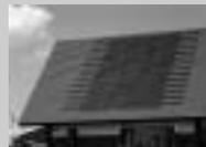
耐久性の高い、ガルバリウム鋼板をはじめ、アルミやステンレスを使用しているため丈夫で長持ち。地震に安心な軽量屋根のうえ、既存屋根との中間に断熱ボード（発泡ポリスチレン）をサンドイッチ。だから断熱性能が他の屋根材と比べ抜群に向上しています!!
