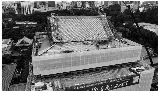
バックング工法で施工中の「増上寺大殿」
