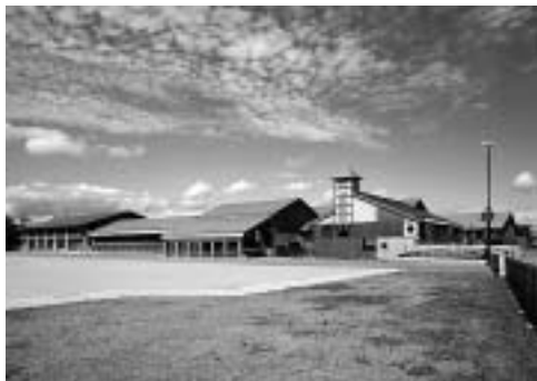
会津美里町立宮川小学校 (福島県大沼郡会津美里町)
