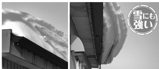
「北海道札幌市に設置した元旦内樋」 2019年1月22日 積雪150cm超
